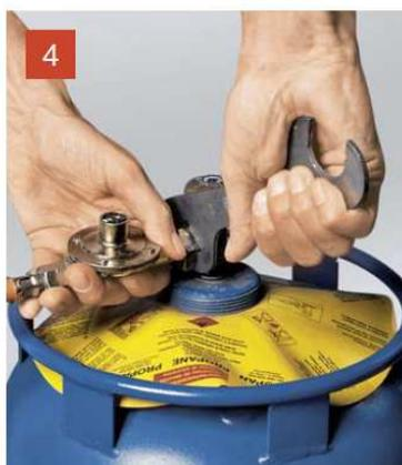
Pour un écrou six pans: avec une clé
