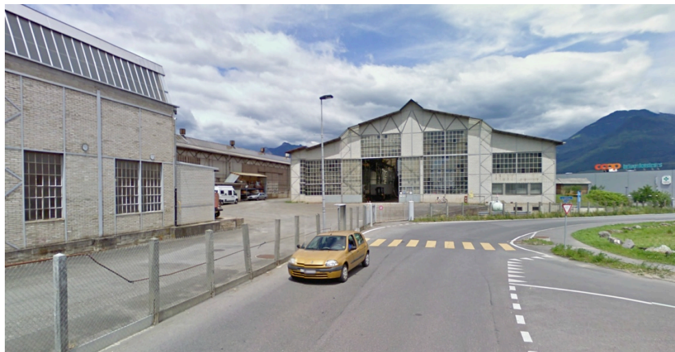
Fig. 27. Vue de l'un des bâtiments du site.
