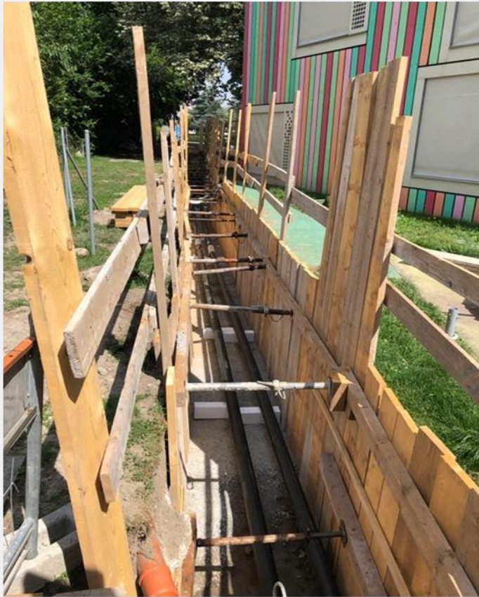
Travaux en cours - Raccordement de l'UAPE au CAD de la SATOM
