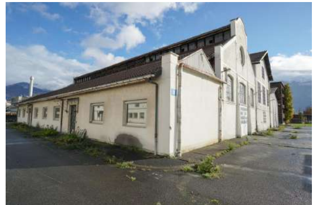
Façades nord-ouest et sud-ouest
