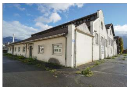
Façades nord-ouest et sud-ouest
