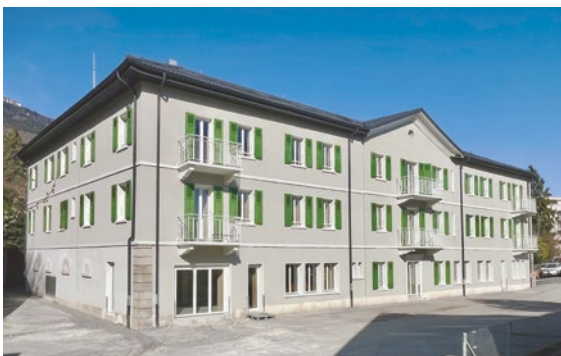
Après les travaux
