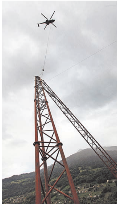
Cinq pylônes ont été ancrés dans le sol, en prévision de l'installation du téléphérique de chantier qui permettra dans un premier temps d'évacuer les anciennes conduites et fondations et par la suite d'acheminer sur le chantier tous les matériaux (bétons, nouvelle conduite, etc..)
